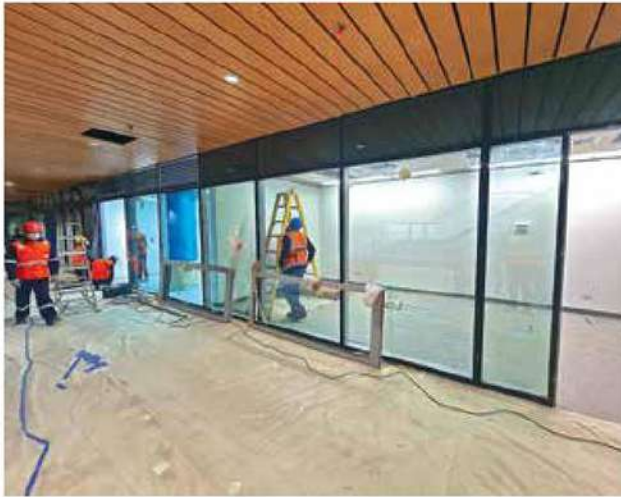
↖ Instalación de puertas batientes en sótano 1
