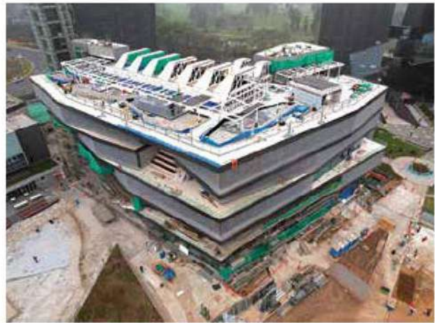
↖ Trabajos en azotea techo verde
