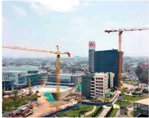
↖ Uso de dos grúas torres en la obra
