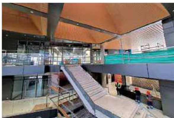
Instalación de PAC en escaleras metálicas
